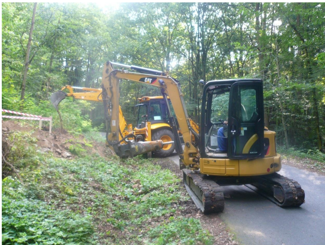
Hloubicí práce v Píseckých horách v rámci stavební fáze projektu
