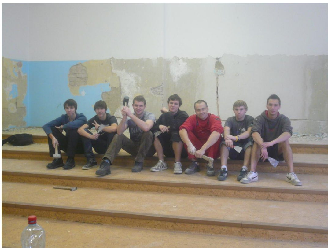
Na začátku – oškrábání staré barvy, otlučení omítky
