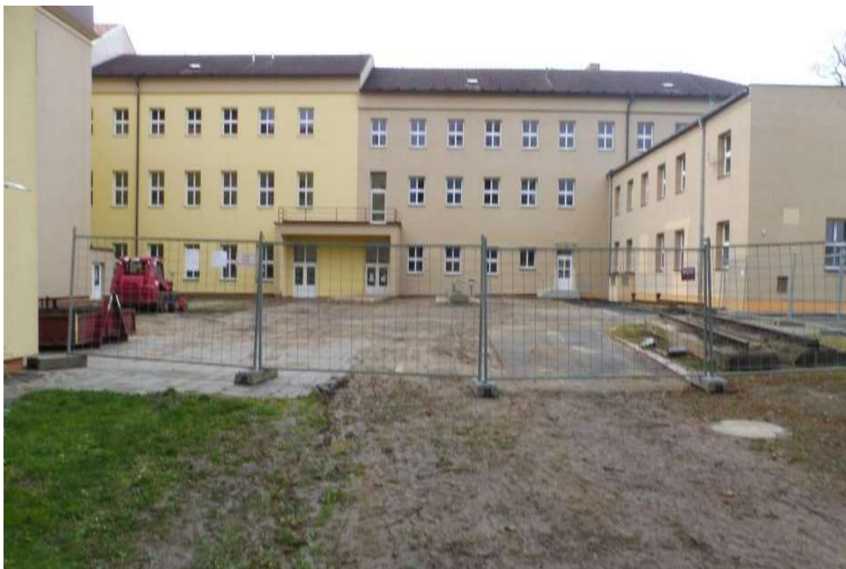
obr. 143 Stav západního křídla před zahájením II. etapy
