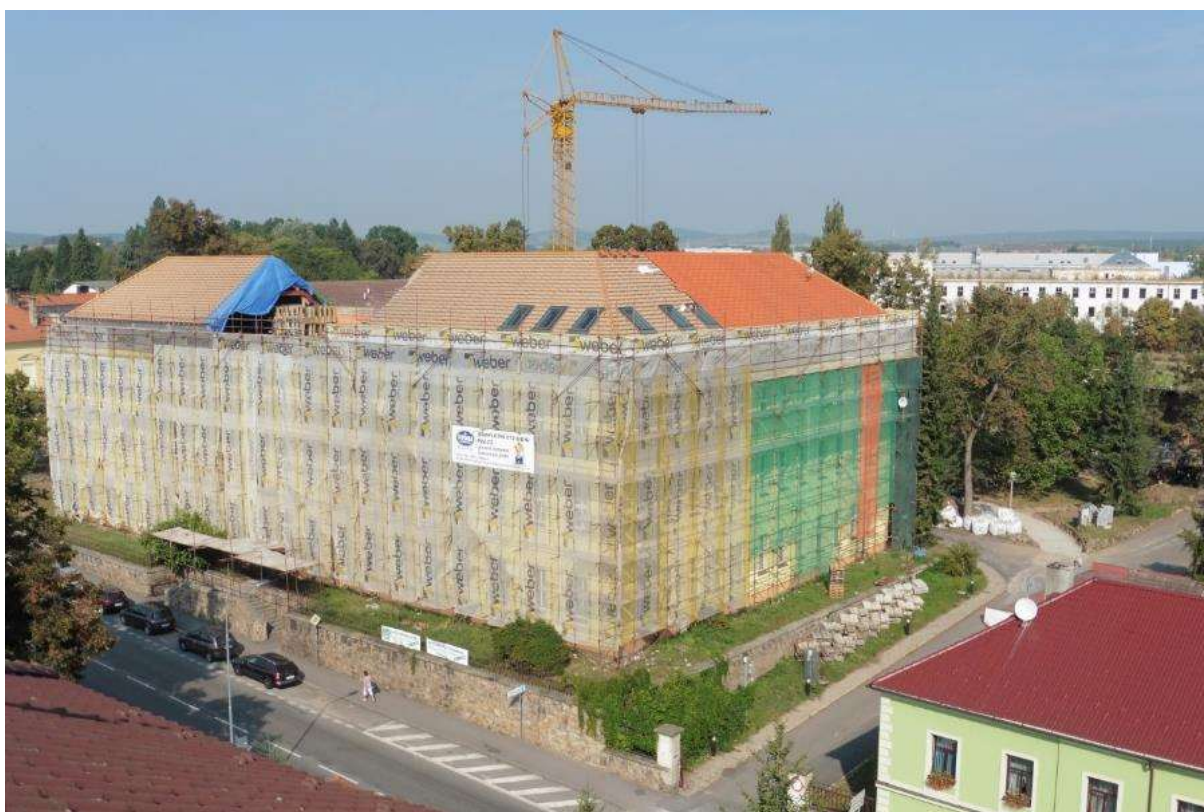
obr. 142 Budova se zvednutým krovem a ½ patra
