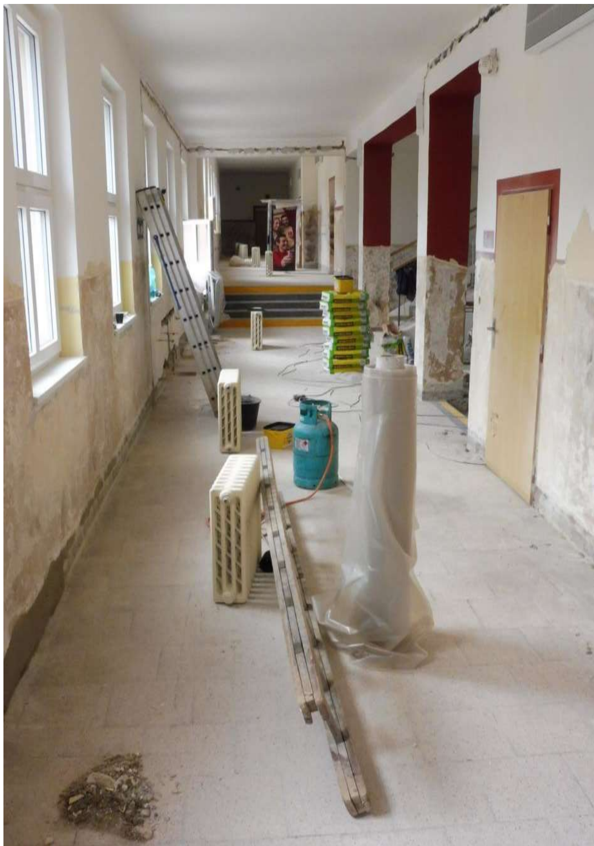
obr. 136 Proměna staršího patra k podobě chodeb nové půdní vestavby
