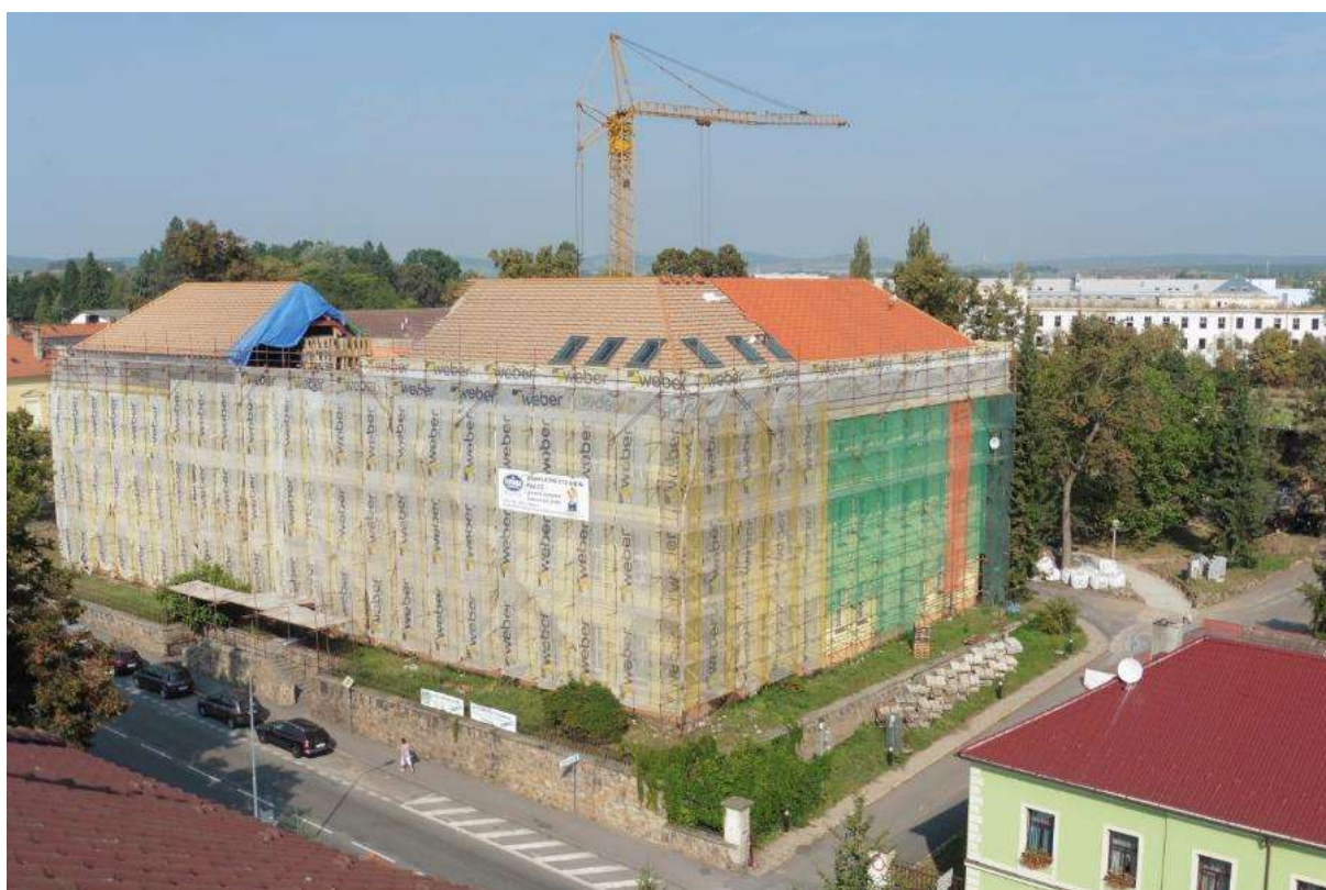
obr. 121 Budova se zvednutým krovem a ½ patra
