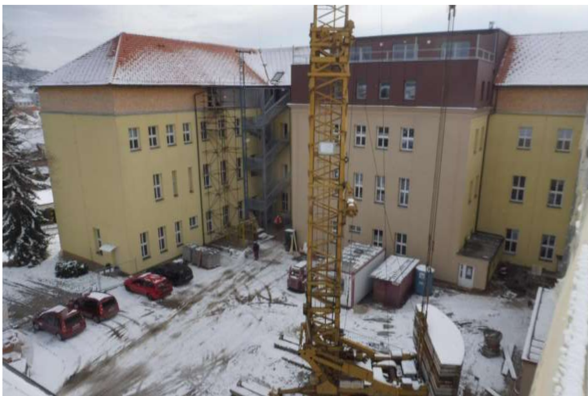
obr. 123 Stav východního křídla při zahájení II. etapy
