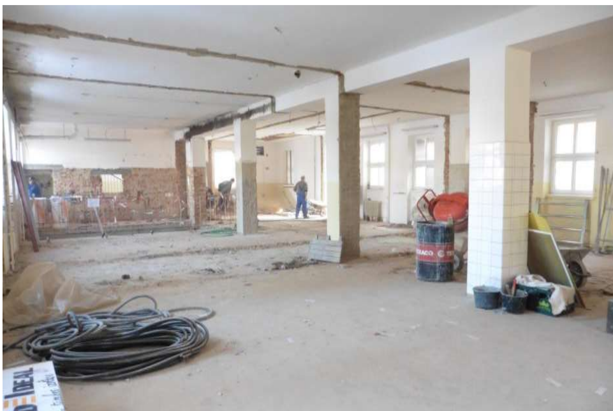
obr. 122 Zahájení rekonstrukce, leden 2017
