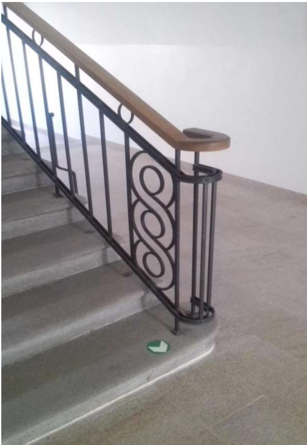
obr. 132 Schodiště po vyjehličkování s novým zábradlím
