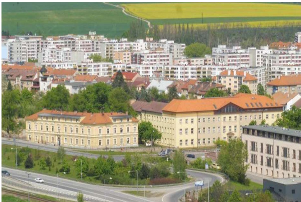
obr. 3 Pohled na budovu školy po dokončené I. etapě půdní vestavby (uprostřed)
