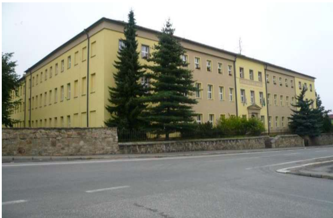
obr. 3 Pohled na budovu školy
